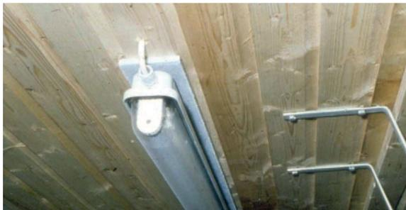
Installation einer Leuchte ohne Kennzeichnung
